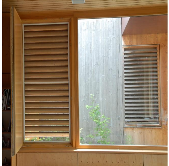
Nachtlüftungsöffnung Albert-Schweitzer-Schule, Foto: ABI, Abteilung Energiemanagement
