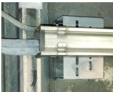
Abbildung 5: räumlich dichte Anordnung von C-Schiene und Kabelkanalhalter
