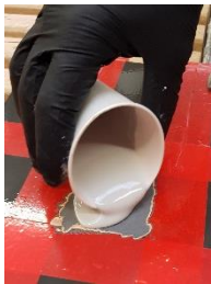
Abbildung 9: angerührten Topcoat auf vorbereitete Stelle auftragen
