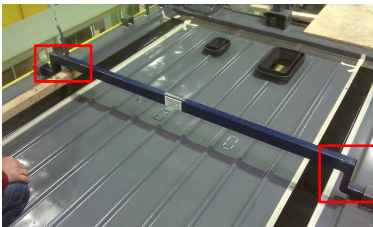
Abbildung 16: Beispieldarstellung Nutzung Stützbalken
