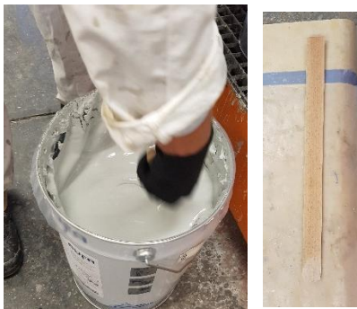
Abbildung 7: Hobbock nach dem Öffnen mit Holzspatel aufrühren
