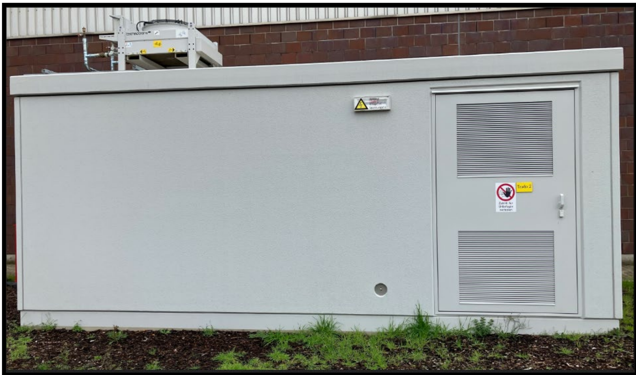
Abbildung 2: Stationsgebäude 2 der Ladeinfrastruktur neben der Halle mit 8 Leistungseinheiten
