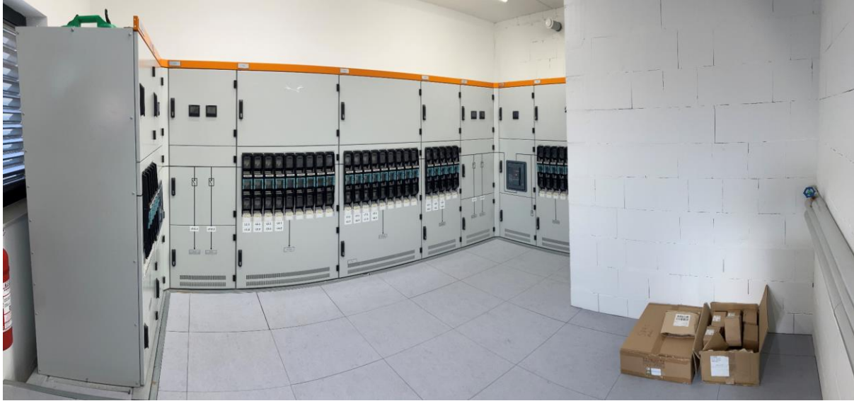
Abbildung 7 - NSHV-LIS, mögl. Aufstellfläche eines Schaltschranks
