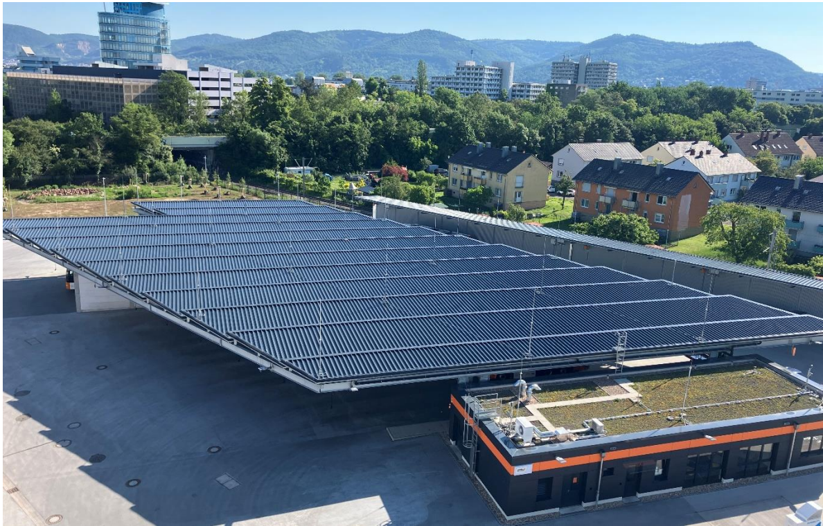
Abbildung 1 – Hauptabstellung mit Blitzschutzstangen
