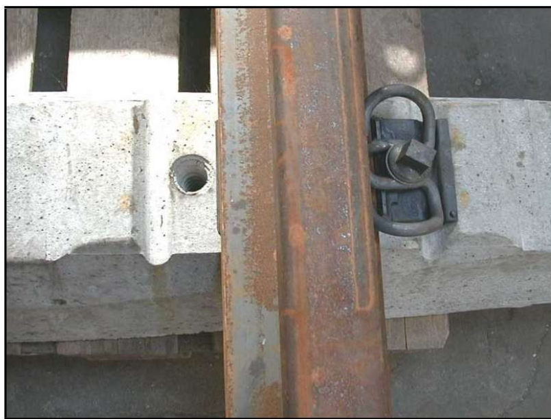
Den Dübel mit dem Ausdrehwerkzeug herausnehmen
