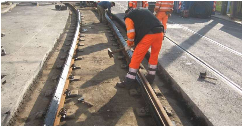
Abbildung 8 Einschlagen der KE
