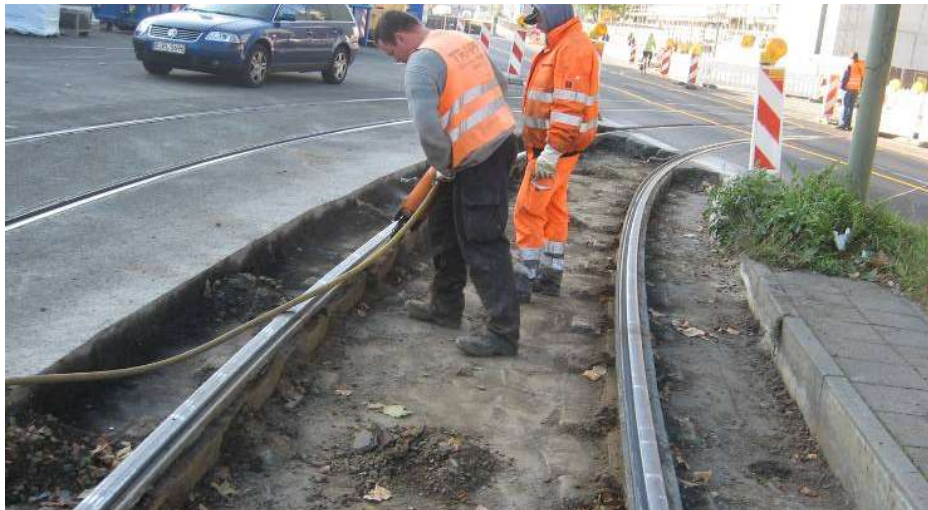
Abbildung 3 Rückbau der Kammerelemente
