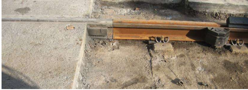
Abbildung 7 erforderlicher Schweißstoß im Anschlussbereich
