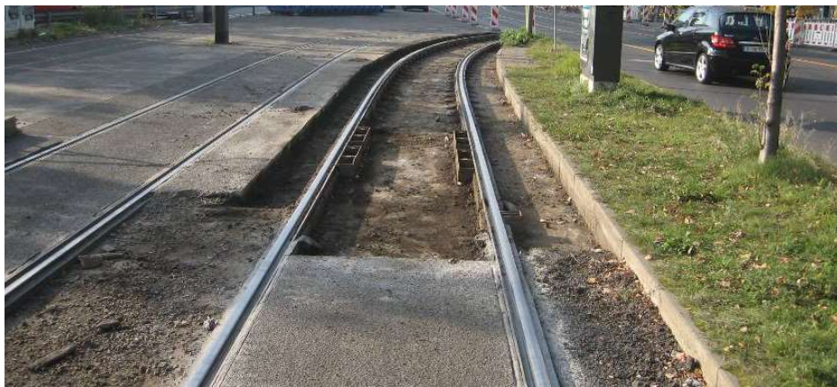
Abbildung 2 Rückbau der Eindeckung
