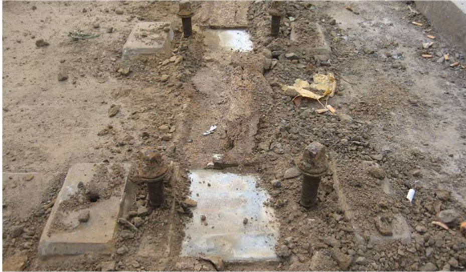
Abbildung 5 freigelegte Schwellenaufleger mit eingedrehten Schwellenschrauben (zum Schutz vor Verschmutzung der Dübellöcher)
