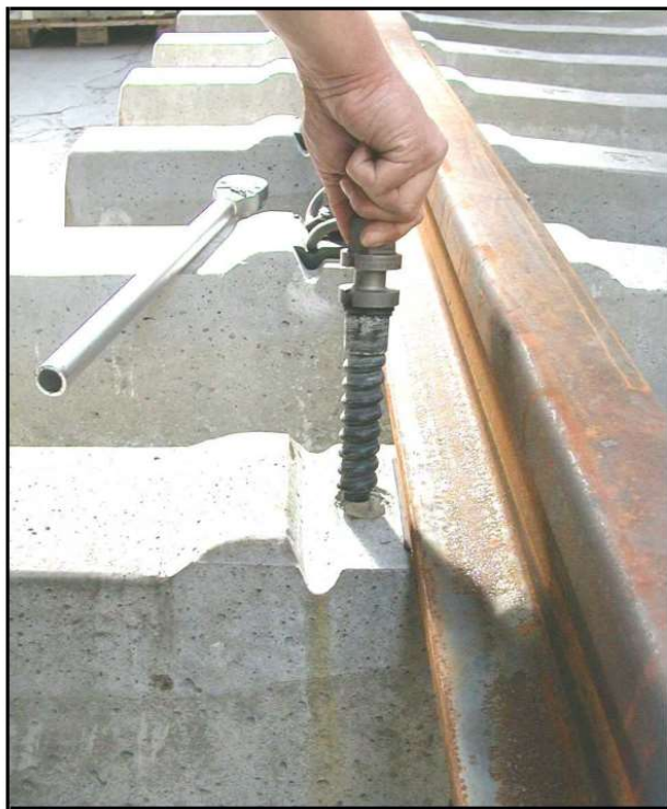
Den Dübel mit dem Ausdrehwerkzeug herausnehmen
