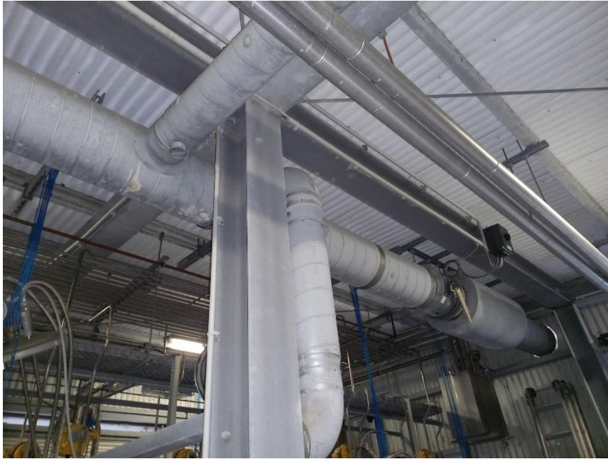
Knotenpunkt Stahltragwerk mit Lüftungsleitung
