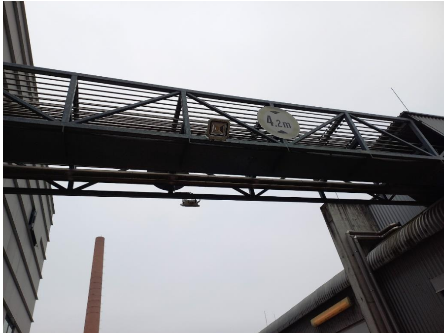
Rohrbrücke zwischen Gasflaschenlager und Technikum
