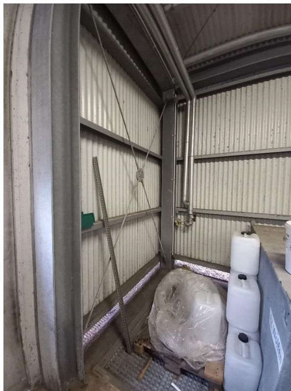
Stahltragwerk mit Verstrebung & Außenwand
