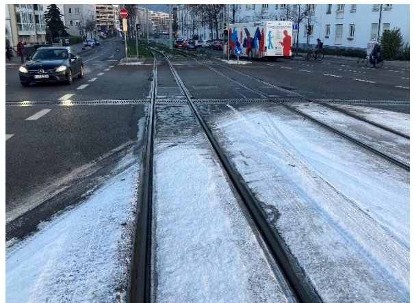
Abbildung 2: Bahnkörper und Schienenauszugsvorrichtung
