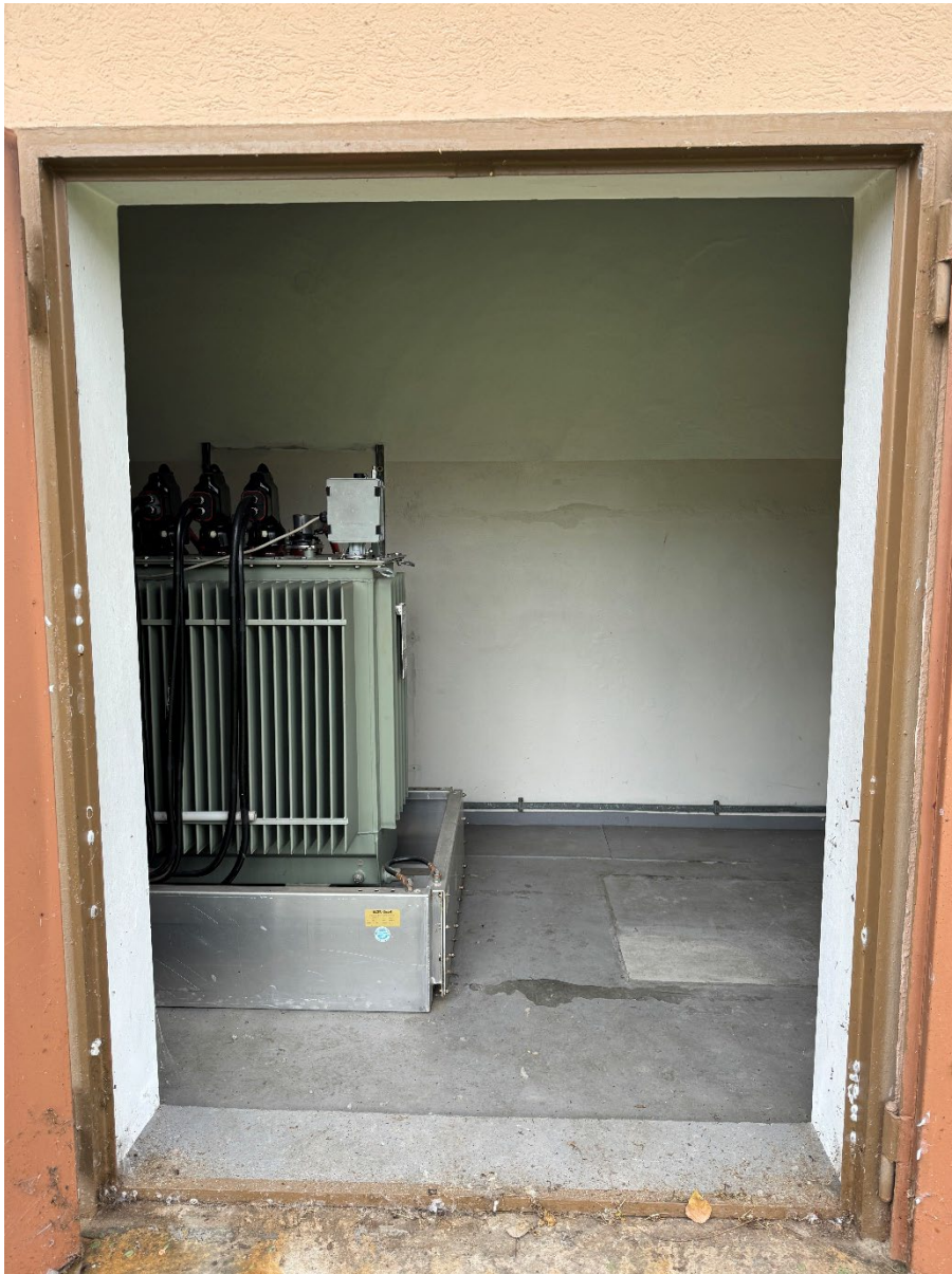
Abbildung 6: EB-Traforaum
